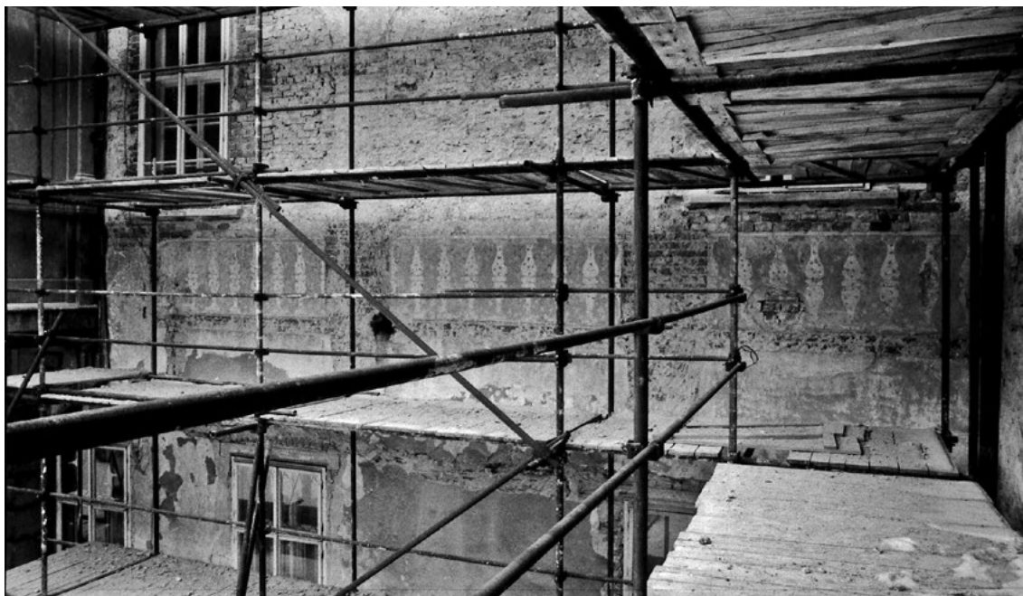
Renesanční sgrafita v podobě kuželkové balustrády na fasádě jižního křídla odhalena při rekonstrukci zámku v letech 1990–1992, zdroj: SZ Dačice
