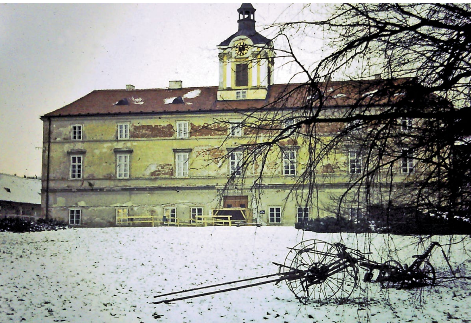
Havarijní stav jižního průčelí zámku v roce 1983, zdroj: SZ Dačice
