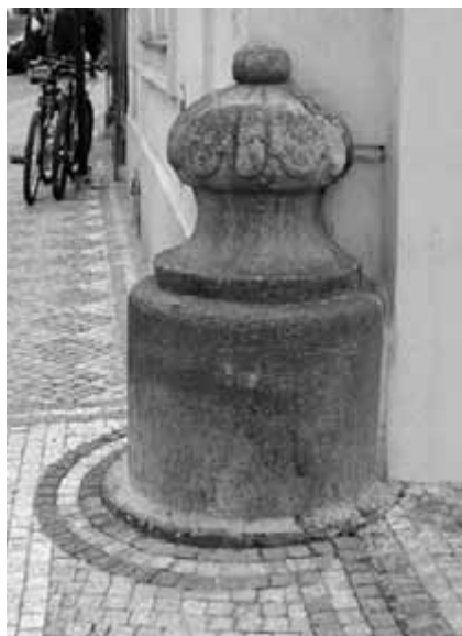
Obr. 100. Nárožní kámen vytvořený ze zlomku kamenné římsy.
