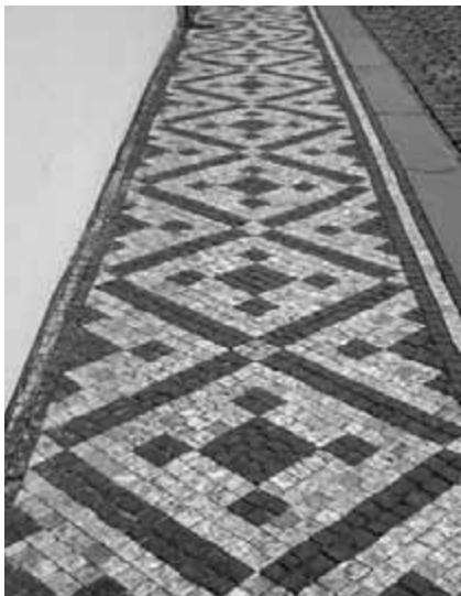
Obr. 7. Hvězdy a kříže, správné provedení s dobrým ukončením vzoru u okraje (propojení pásů) a vhodnou vícepramennou bordurou. Jako středový prvek bývala nejčastěji používána čtyřlístá rozeta nebo čtverec.
