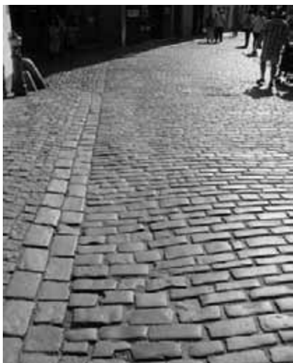
Obr. 29. Řádková dlažba ulice z opracovaných hranolů zhruba stejné šířky. Úžlabí (z dvou řad kostek) člení plochu na vozovku a plochu podél budov, patrný je vydutý příčný profil vozovky.
