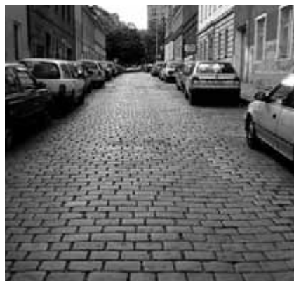
Obr. 40. Velká dlažba kladená do řádků kolmo k ose vozovky.
