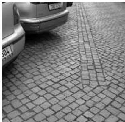
Obr. 51. Dlažba vozovky z drobných kostek v řádkové úhlopříčné skladbě.
