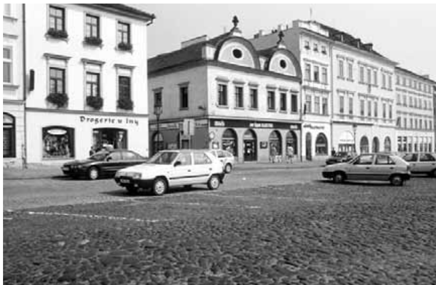
Obr. 7. Ve střední části plochy některých náměstí zůstala zachována starší dlažba z nepravidelného kamene, zatímco vozovky na jejich obvodu jsou vydlážděny kostkami. Podobná řešení, která již mají svou historickou hodnotu a vyhovují dopravnímu provozu, je třeba zachovat.
