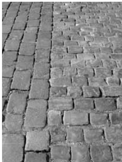
Obr. 41. Dlažba vozovky kladená v řádcích na koso k podélné ose. Vlevo je patrná velká dlažba, vpravo drobná dlažba.
