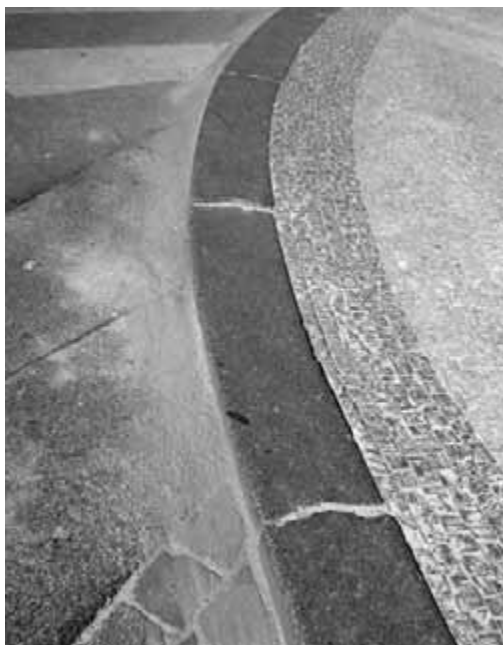
Obr. 30. Běžné masivní žulové obrubníky, kladené na sucho a se zámek směřujícím doprava.
