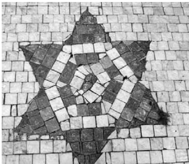
Obr. 25. Ukázka nevhodnosti řezané mozaiky k provedení jemnějších detailů.
