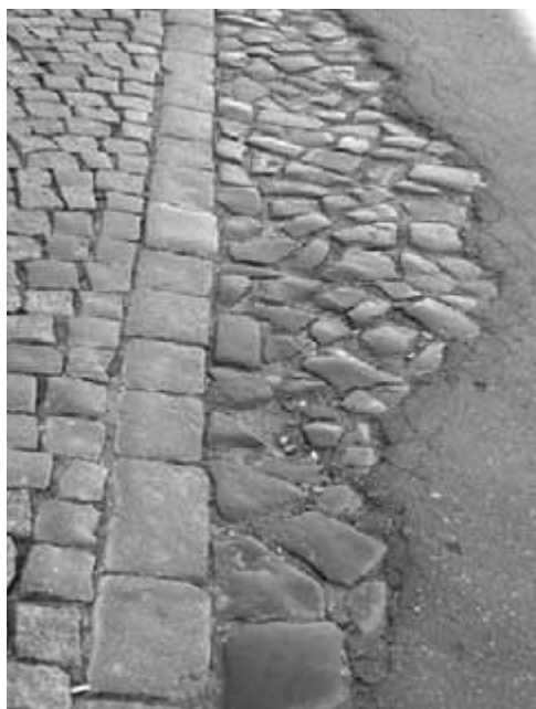
Obr. 23. Starší, památkově hodnotné dlažby zůstaly někde zachovány pod asfaltovým povlakem nebo jinou novější povrchovou úpravou. Úkolem pracovníků památkové péče je upozornit na jejich existenci a snažit se odvrátit jejich likvidaci.
