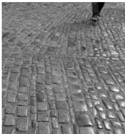
Obr. 25. Dlažba z opracovaných kamenů kladených do řádků.
