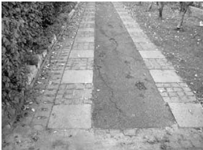
Obr. 72. Pokud jsou betonové dlaždice, asfaltový povlak nebo betonová mazanina (úpravy v prostředí starší zástavby samozřejmě nevítané) původní součástí areálu stavby z období moderní architektury, neměly by být nahrazeny kamennou dlažbou ani jinou povrchovou úpravou.
