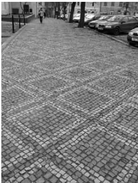
Obr. 79. Původní dvoubarevná chodníková mozaika s pravouhlým vzorem (rám s výplní).
