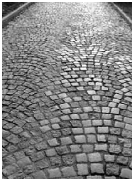
Obr. 53, 54. Dlažba z drobné kostky kladená do kroužků. Ohlazený líc původních kostek kontrastuje s hrubým povrchem nových (obr. 53).
