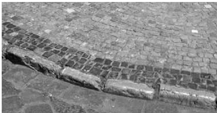
Obr. 33. Nejstarší typ obrubníků. Jsou úzké, mramorové, kladené na výšku. Stejný tvar mají i pozdější subtilní obrubníky žulové.
