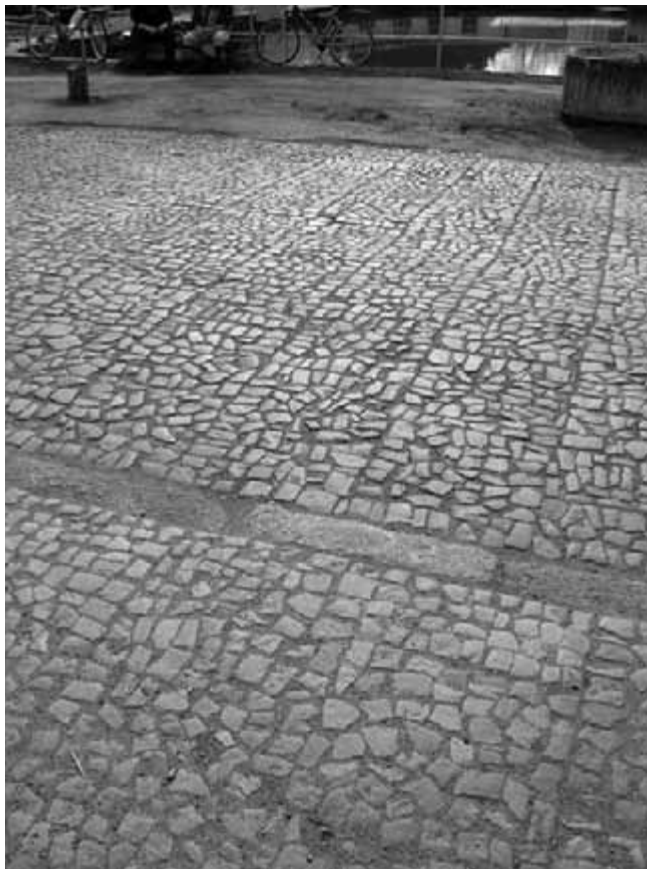
Obr. 88. Zvláštní dlažba vozovky z nepravidelných kamenů (pravděpodobně systém Gensal).
