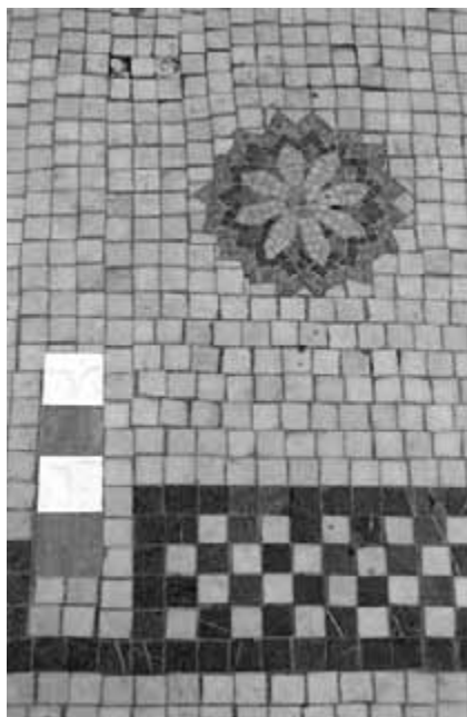
Obr. 62. Detail kopie takzvané italské mozaikové dlažby chodníků (novodobé kostičky o hraně cca 3 cm).
