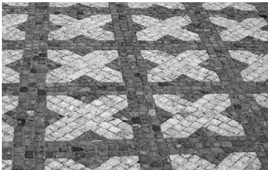
Obr. 12. Nevhodné předláždění se zbytečným použitím nového materiálu. Původní měkkost a malebnost vzoru (viz obr. 11) byla zcela setřena.
