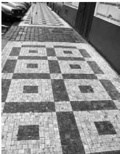
Obr. 3. Nesprávné provedení vzoru sedmdesátka s dámou. Středový čtverec je čtyřřadý jako ostatní části vzoru, ale má být větší.
