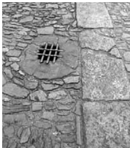
Obr. 107. Původní technický prvek: kombinace kamenné obruby a pevné kovové mřížky (kryjící snad vpust dešťové kanalizace).
