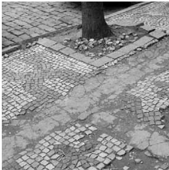
Obr. 29. Nesprávné lemování plochy u paty stromu. Vložené prvky, včetně rabátek, se bordurou v chodníkové mozaice nezvýrazňovaly. Hodnotným prvkem je krycí mříž.
