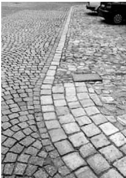
Obr. 44, 45. Srovnání drobné kostky s jinými dlažebními materiály.
