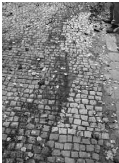
Obr. 111. Původní tmavá chodníková mozaika dochovaná pod asfaltovým kobercem a původní světlá mozaika dochovaná bez asfaltového přelivu.
