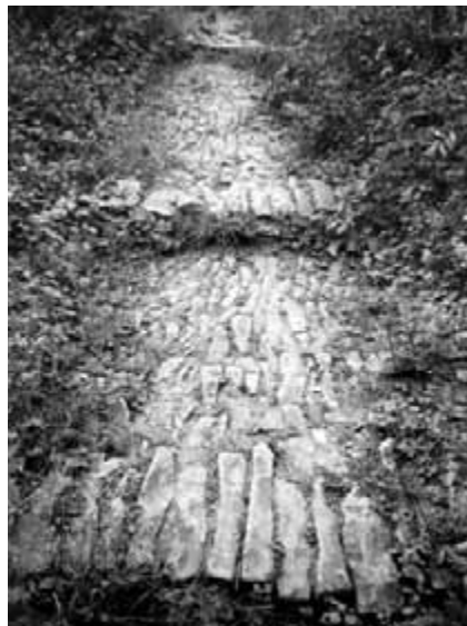
Obr. 23. Vrstevnatý kámen tvaru hranolu, z něhož byly vytvořeny „jezdecké stupně“ ke kostelu (nevhodné z provedení technického hlediska).
