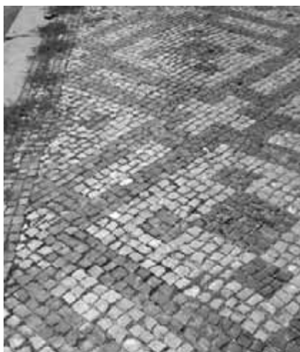
Obr. 5. Rámy s draky na koso, varianta s kříží v křížení, správné provedení. Vzor má dobré proporce i diagonální půlení prvků a vhodnou vícepramennou borduru.
