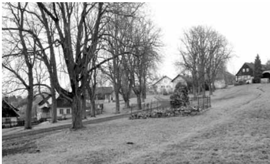
Obr. 57. V zájmu zachování věrohodného výrazu památkově významných venkovských staveb a sídel je nutné respektovat starší úpravy cest, návší a dvorů. Zpevněné cesty mnohde původně zabíraly jen menší část plochy travnatých návší.
