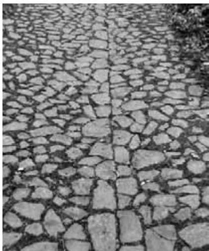
Obr. 6. Dochovaná dlažba uličky z nepravidelného kamene, středová podélná stružka pro odvedení dešťové vody.
