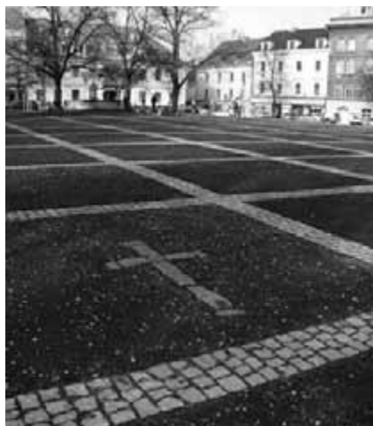
Obr. 106. Plocha náměstí je dělena třemi řádky drobné kostky na jednotlivá pole, vyplněná asfaltem se zaválcovaným štěrčkem. Kříž z velkých kamenů značí památné místo.
