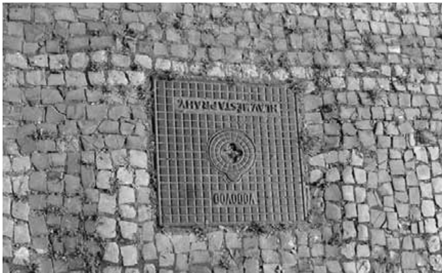
Obr. 26. Vložené prvky se nezdůrazňovaly žádným druhem lemu nebo ozdobné bordury. Šlo o to, aby se pokud možno neuplatňovaly.
