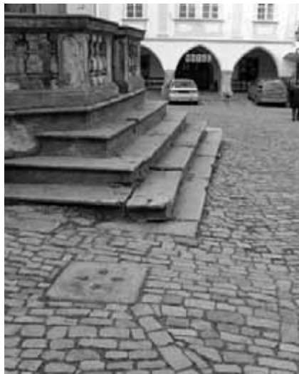
Obr. 104. Kamenná deska sloužící dříve jako podstavec nedochované brány vyznačený dlažbou z velkých nepravidelných kamenů.
