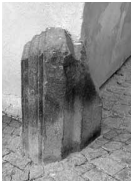
Obr. 100. Nárožní kámen vytvořený ze zlomku kamenné římsy.
