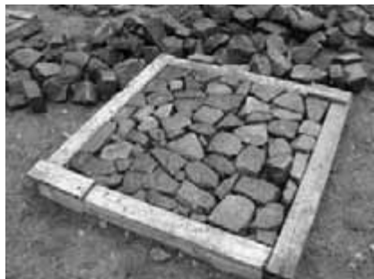
Obr. 112. Vzorek způsobu dláždění z původní vybourané dlažby. Kvůli úspoře materiálu jsou kónické kameny chybně kladeny na plocho.
