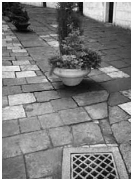
Obr. 31. Dlažba z kamenných desek. Původní, světlé desky jsou z kvalitní horniny, zatímco novodobé, tmavé desky, prorůstající mech, jsou vyrobeny z nekvalitní nasákové horniny.
