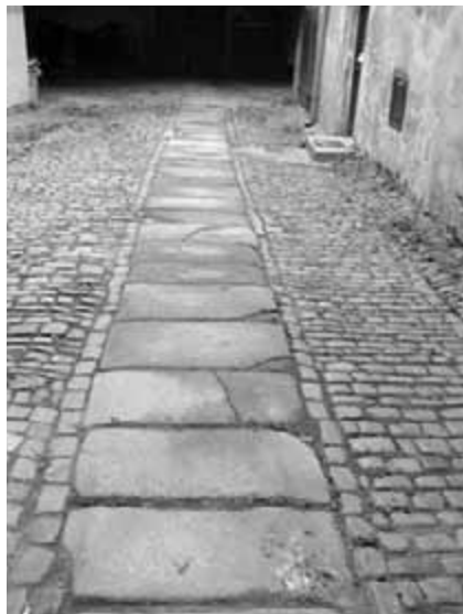
Obr. 34. Vjezd do dvora, řádková dlažba je zpevněna podélnými jednořadými liniemi, středová část je kladená ve vypuklém příčném profilu s vloženou „cestou“ pro chodce ze žulových desek, podél domů vede úžlabí z jedné řady kamenů.
