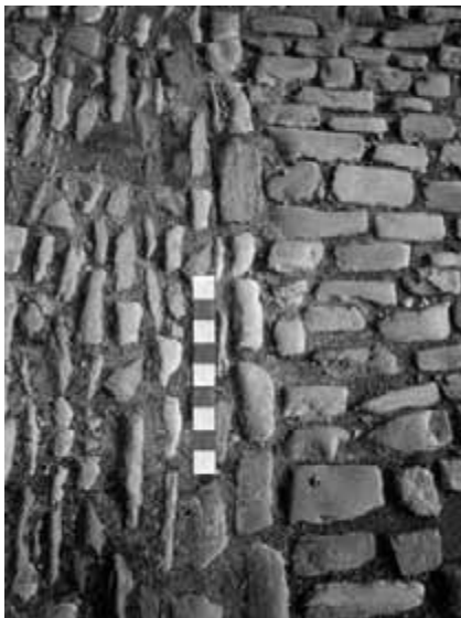
Obr. 22. Detail řádkové dlažby z vrstevnatého kamene. Vpravo je vozovka z širších kamenů lepší kvality; vlevo doplňková plocha z užších a méně kvalitních kamenů.
