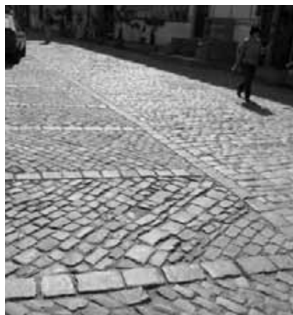
Obr. 26. Řádková dlažba ulice z opracovaných hranolů. Patrný je vydutý příčný profil vozovky a úžlabí, plocha mezi vozovkou a chodníkem je ztužena příčnými řadami (mezilehlá pole z řádkové dlažby kladené na koso s prostrídanými směry).
