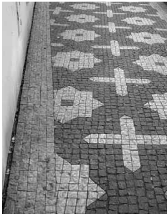
Obr. 20. Nesprávné použití vzoru pro daný tvar chodníku. V rámci šířky chodníku se má uplatňovat vždy celý prvek vzoru nebo jeho polovina, nikoliv neúplné, klínovitě se zmenšující výseky.
