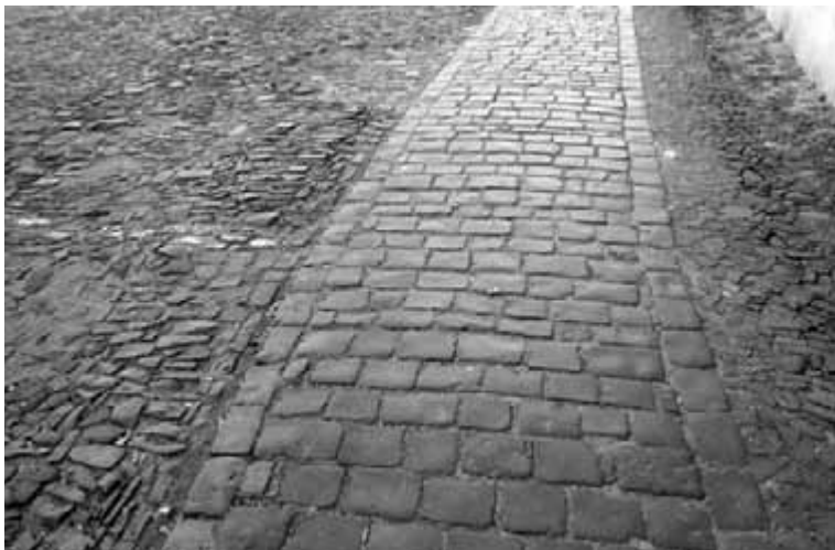
Obr. 20. Je-li část starší komunikace vydlážděna mladší, ale již památkově hodnotnou dlažbou, je třeba tento stav zachovat. Sjednocení dlažby by nebylo správným řešením.
