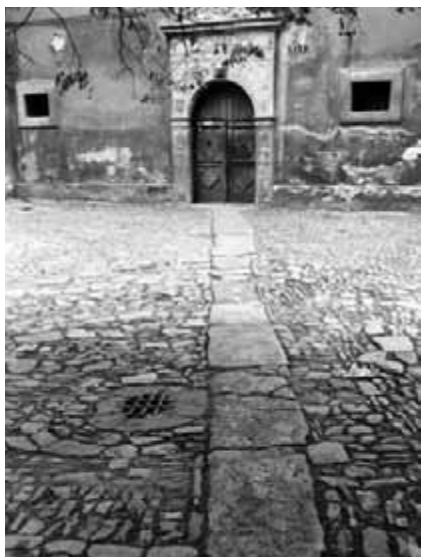
Obr. 36. Pěší spojka mezi kostelem a farou vytvořená z desek v dlažbě z vrstevnatého a nepravidelného kamene.
