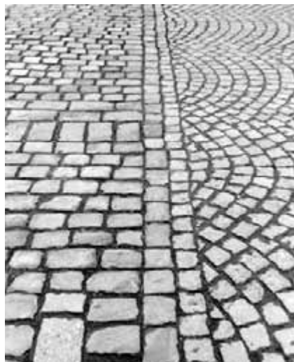
Obr. 44, 45. Srovnání drobné kostky s jinými dlažebními materiály.
