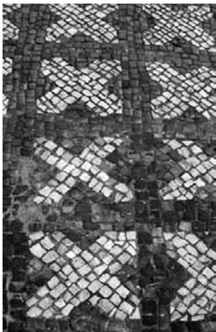
Obr. 11. Původní vzor s kříží kolem kostela sv. Petra. Správné provedení s ojedinělým bílým mramorem, použitým vzhledem k významu budovy.
