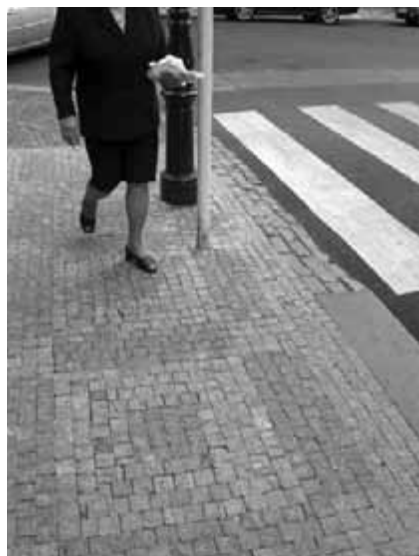
Obr. 65. Původní vzor „pražské“ chodníkové mozaiky zopakovaný v nové řezané mozaikové dlažbě. Použité horniny nenabízejí dostatečně odlišné barevné odstíny.
