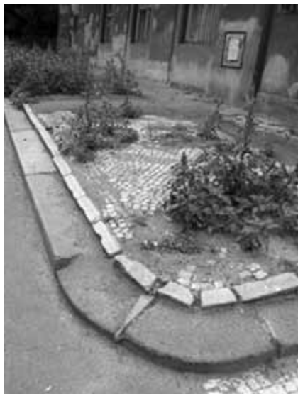
Obr. 94. Srovnání novější, široké žulové a starší, vápencové obruby. (Ta byla zprvu tvořena chodníkovými deskami kladenými nastojato.)
