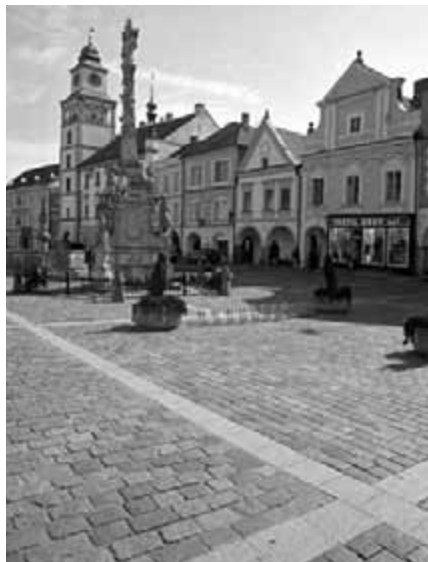
Obr. 8. Při předlažbách náměstí starších měst bývá jejich plocha členěna pruhy výrazně odlišné dlažby. Pokud není taková změna dochovaného stavu návratem k dobře doložené starší povrchové úpravě, je to nevhodný zásah do historického prostředí. Stejně jako obnova fasád starších budov by ani úprava náměstí a ulic v historických částech měst neměla být předmětem volné architektonické tvorby.
