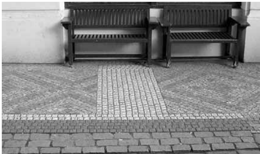
Obr. 21. Nesprávné provedení přechodu pro nevidomé bez respektování vzoru chodníku.
