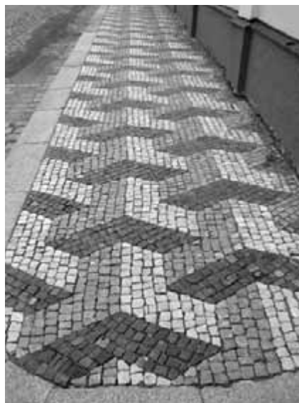
Obr. 63. Původní chodníková mozaika složená do třibarevného vzoru.
