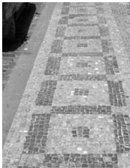
Obr. 4. Nesprávné provedení vzoru sedmdesátka s dámou. Středový čtverec je výrazně menší než ostatní části vzoru, ale má být větší. Příklad je o to horší, že byla použita původní štípaná mozaika, z níž mohl být bez problému proveden kterýkoli z historických vzorů.
