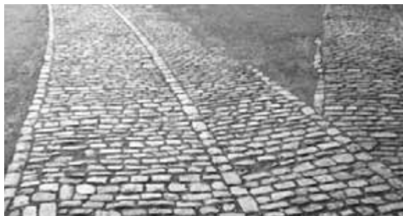
Obr. 20. Mlatová úprava s jízdními pruhy dlážděnými opracovaným kamenem klade-ným do řádků.
