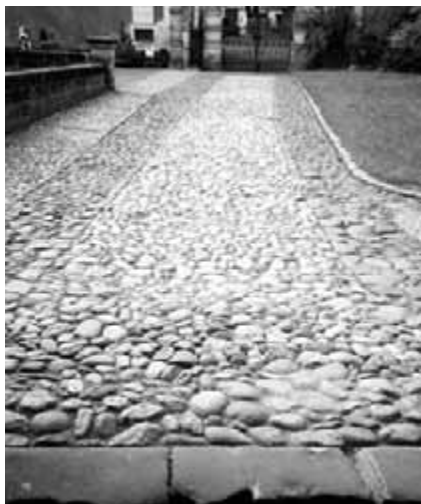
Obr. 15. Valounová dlažba příjezdové cesty.
