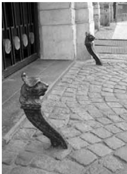
Obr. 99. Litinové prvky ochraňující zdivo ostění vjezdu do dvora.
