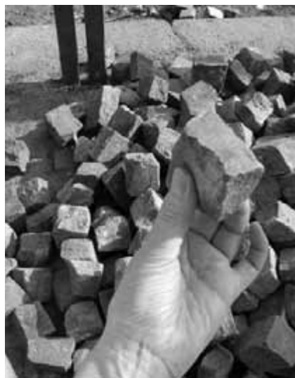
Obr. 74. Kamének původní chodníkové mozaiky s ohlazenou horní plochou, kladený na výšku v dlažbě o tloušťce cca 6 cm.
