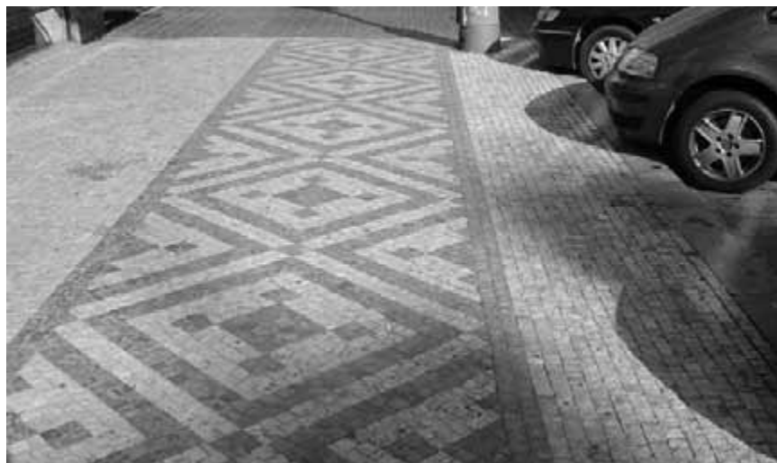
Obr. 16. Nesprávné rozvržení vzoru na ploše chodníku. Vzor má pokrývat celou plochu chodníku, a nikoliv působit jako běhoun. V některých místech by bylo možné aplikovat vzor na šířku několikrát.
