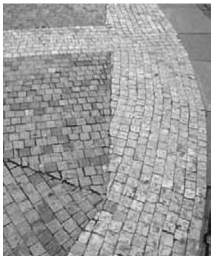
Obr. 60. Novodobá, strojově řezaná mozaiková dlažba. Ukázka špatného výsledku vzniklého snahou o kopii původní kubistické dlažby.
