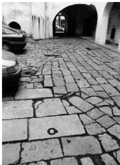
Obr. 32. Dlažba dvora z druhotně použitých desek ze sliveneckého mramoru, z nichž se před zavedením zvýšených chodníků tvořily v Praze cesty pro chodce.
