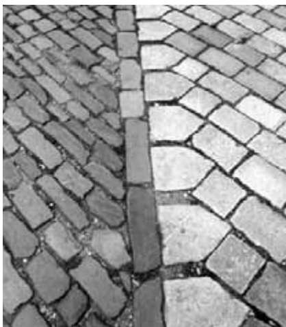
Obr. 39. Dlažba náměstí v úhlopříčné skladbě. Vlevo je patrný vrstevnatý kámen kladený v řádcích podle šířky, vpravo pak velká dlažba, ukončená takzvanými biskupskými čepicemi.
