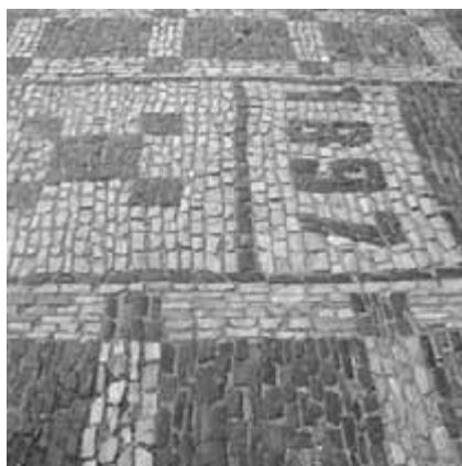
Obr. 70. Původní chodníková mozaiková dlažba z podélných prvků (hralnků), kopie pravouhlého vzoru s datací.
