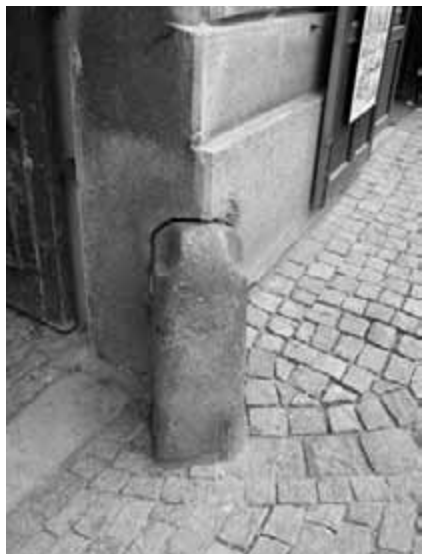
Obr. 96. Nárožní kámen chránící ostění vjezdu do dvora.
