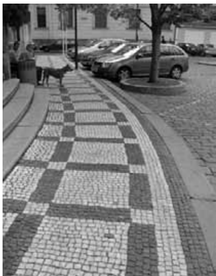
Obr. 73. Původní chodníková mozaika umožnila díky proměnné velikosti kosek položení pravoúhlého vzoru, který kopíruje zakřivení chodníku.
