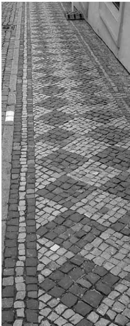
Obr. 10. Šachovnice (dáma), správně obnovené provedení vzoru s vícepramen- nou bordurou a úzkými žulovými obrubníky.
