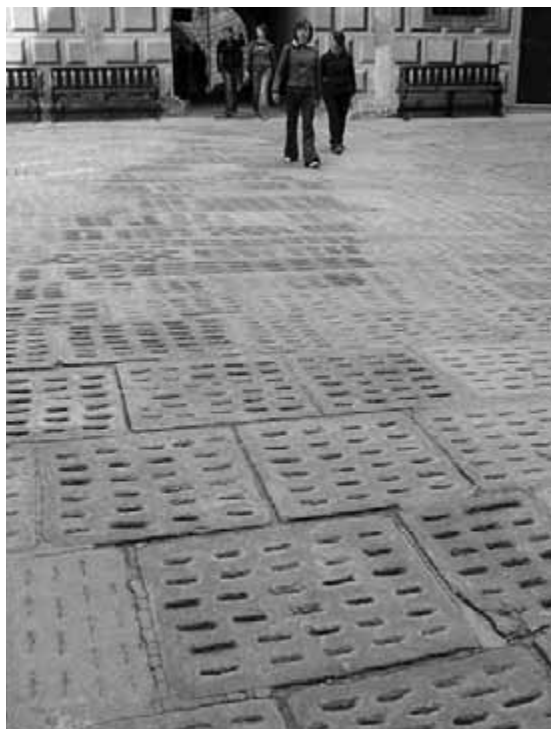
Obr. 33. Kamenné desky s vytesanými drážkami, které zřejmě měly zabránovat uklouznutí.
