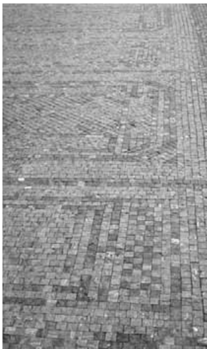
Obr. 18. Tentýž vzor v současné době. Snaha o obnovu původního stavu nedosáhla cíle především pro použití nekонтрастního materiálu (nebyl použit bílý mramor, kterým se na jiných místech plýtvá) a řezané mozaiky. Nákladně obnovený vzor je nezřetelný.
