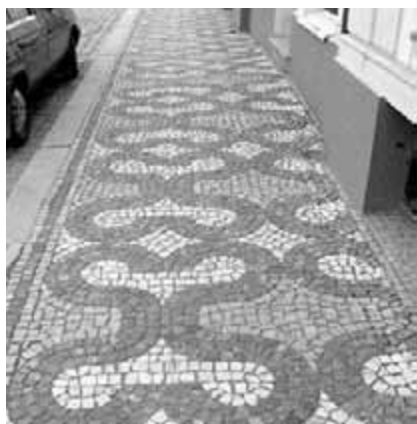
Obr. 69. Původní chodníková mozaika z krychliček v tříbarevném vzoru.
