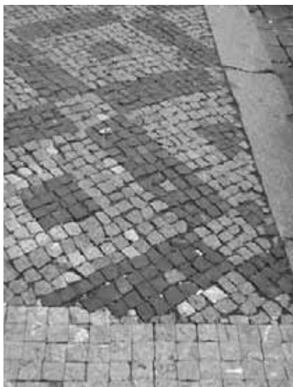
Obr. 64. Srovnání původní sekané chodníkové mozaiky s novou řezanou mozaikovou dlažbou.
