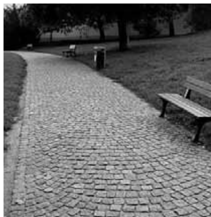
Obr. 53, 54. Dlažba z drobné kostky kladená do kroužků. Ohlazený líc původních kostek kontrastuje s hrubým povrchem nových (obr. 53).
