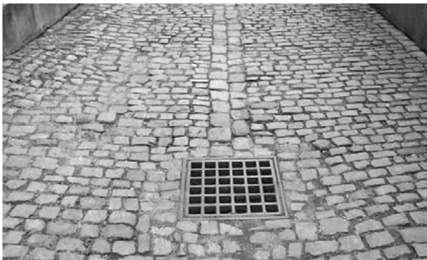
Obr. 103. Litinová mříž tradičního typu v dlažbě z opracovaných křemencových kamenů.
