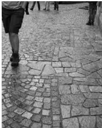
Obr. 105. Novodobá úprava: půdorys nedochované brány vyznačený dlažbou z velkých nepravidelných kamenů.
