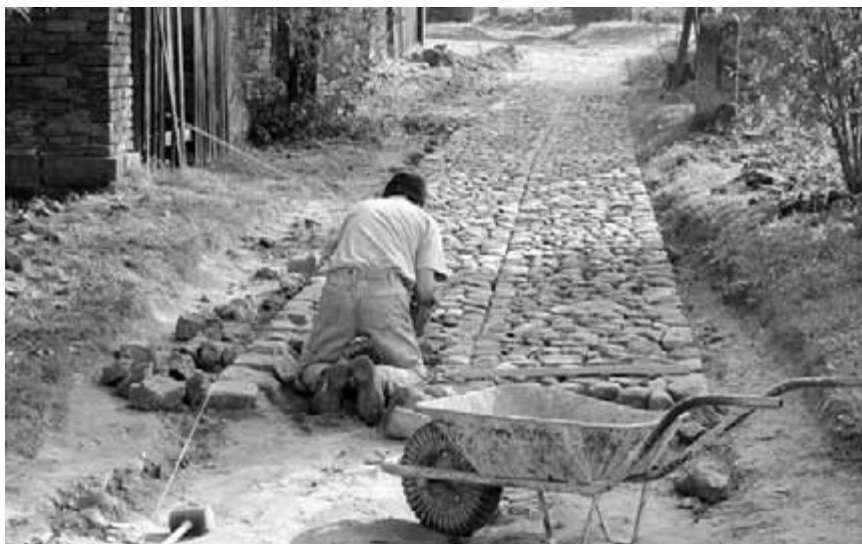
Obr. 59. Příklad obnovy vesnické cesty dlážděné nepravidelným kamenem a spádované do osy komunikace.
