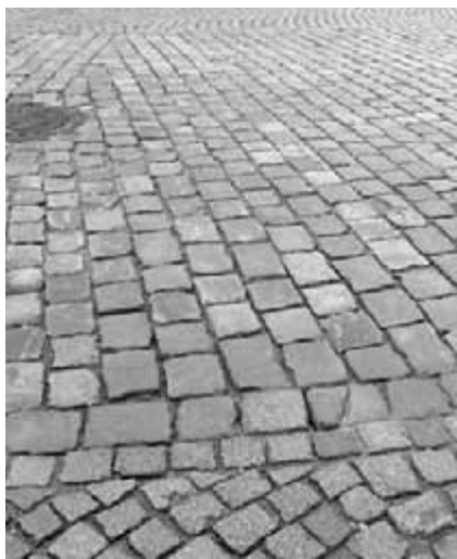
Obr. 27. Dlažby ze zlatavého křemence a modrošedé žuly se odlišují tvarem a způsobem ohlazení.
