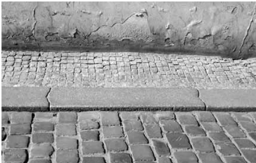
Obr. 30. Běžné masivní žulové obrubníky, kladené na sucho a se zámek směřujícím doprava.
