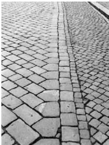
Obr. 41. Dlažba vozovky kladená v řádcích na koso k podélné ose. Vlevo je patrná velká dlažba, vpravo drobná dlažba.
