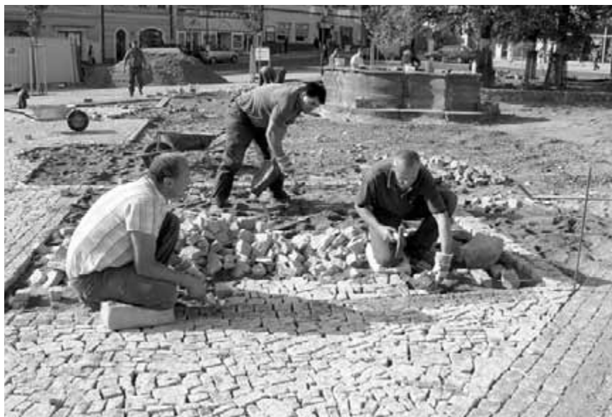
Obr. 115. Dlažební práce vyžadují zkušenost, zručnost i dobrou fyzickou kondici.
