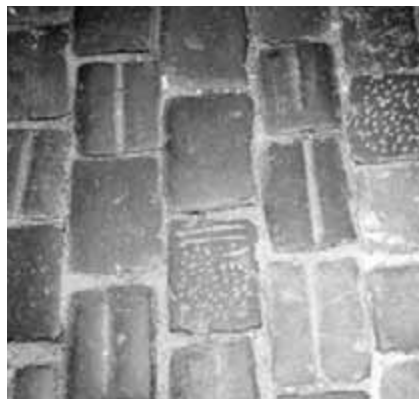
Obr. 42. Velká dlažba, kladená do řádků. Kostky byly po ohlazení zdrsněny podélnými drážkami a vrypy.
