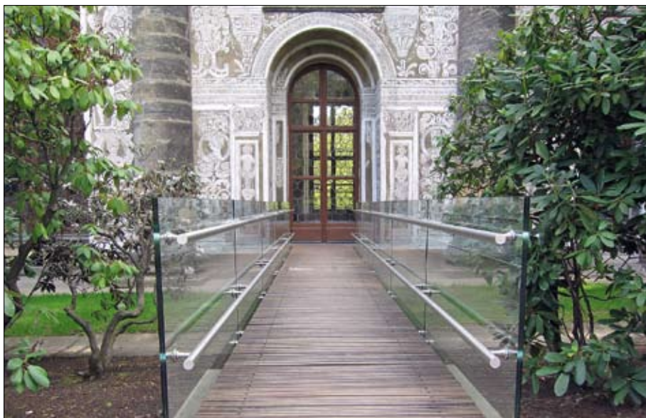
Obr. 8: Příklad troalého způsobu zajištění bezbariérového přístupu. Most, který překlenul snížený terén před Míčovnou Pražského hradu, umožňuje nyní i návštěvníkům na vozíku bezbariérově vstupovat do jejího interiéru. (Foto M. Jančo)
